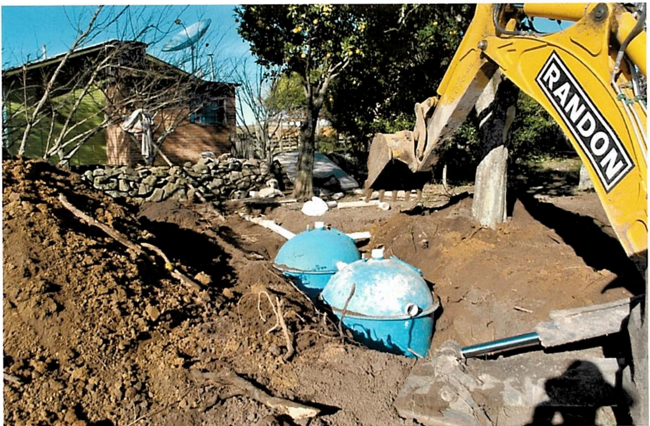
Instalação do sistema de tratamento das águas servidas – Programa Água Limpa
