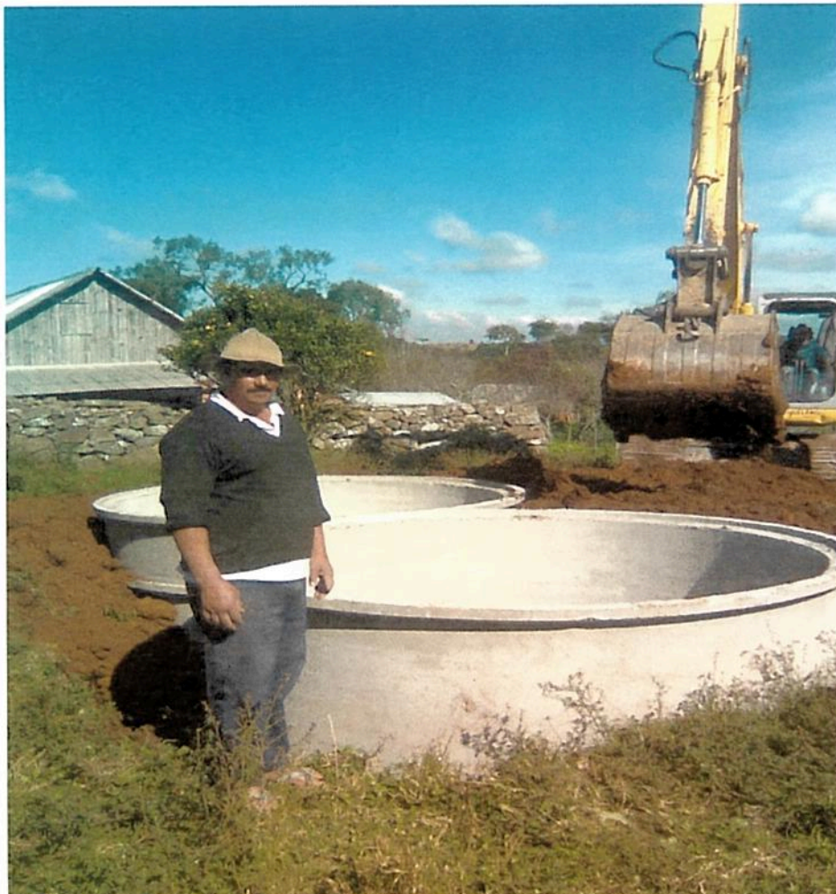
Instalação de esterqueiras – Programa Água Limpa
