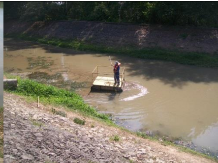
Limpeza do canal de derivação
