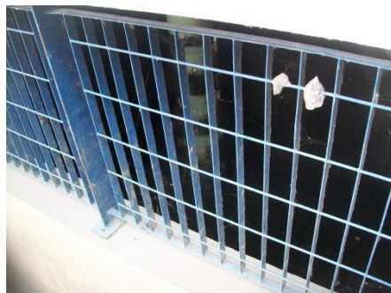
Poço de Sucção
