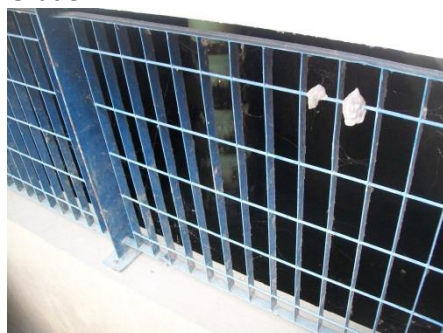
Poço de Sucção
