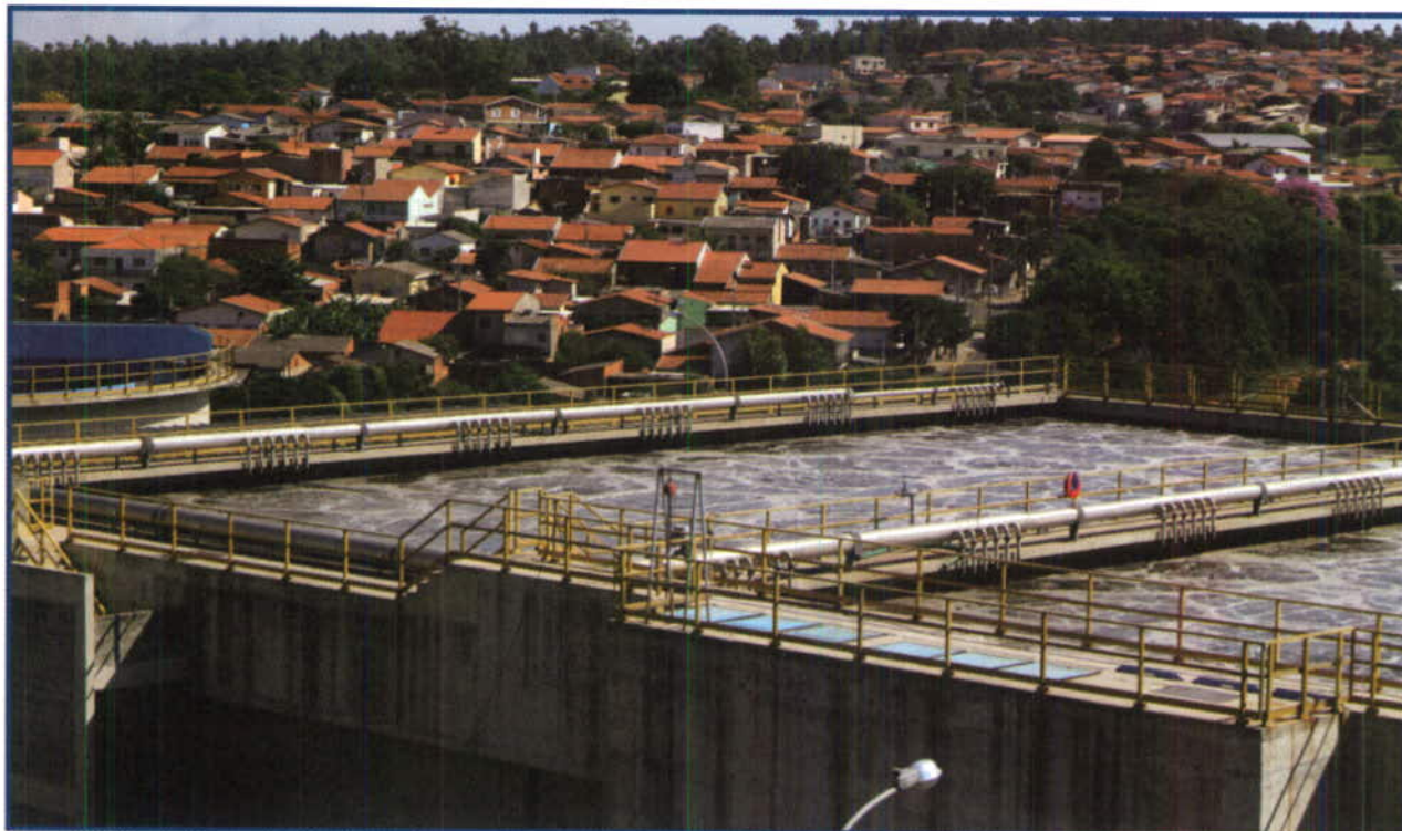
■ Figura 6 – Tratamento de esgoto – ETE Piçarrão, em Campinas (SP) – Foto: Tomas May ■ Picture 6 – Sewage treatment – ETE Piçarrão, in Campinas (SP) – Photo: Tomas May
