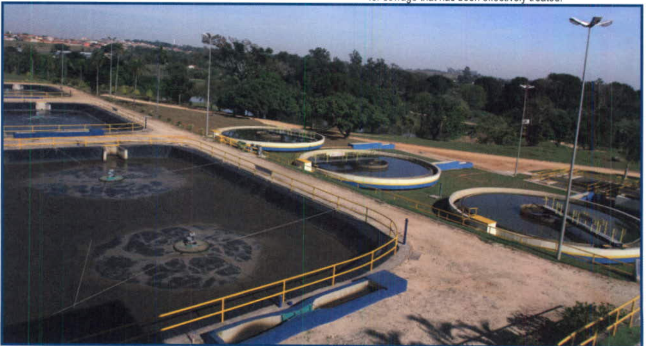
■ Figura 22 – Tratamento de esgoto – ETE Jaguariúna, em Jaguariúna (SP) – Foto: Tomas May
