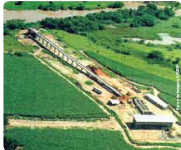
Assim como esta instalação de captação da SABESP no Rio do Peixe (SP), inúmeras outras são destinadas ao abastecimento público de água.
