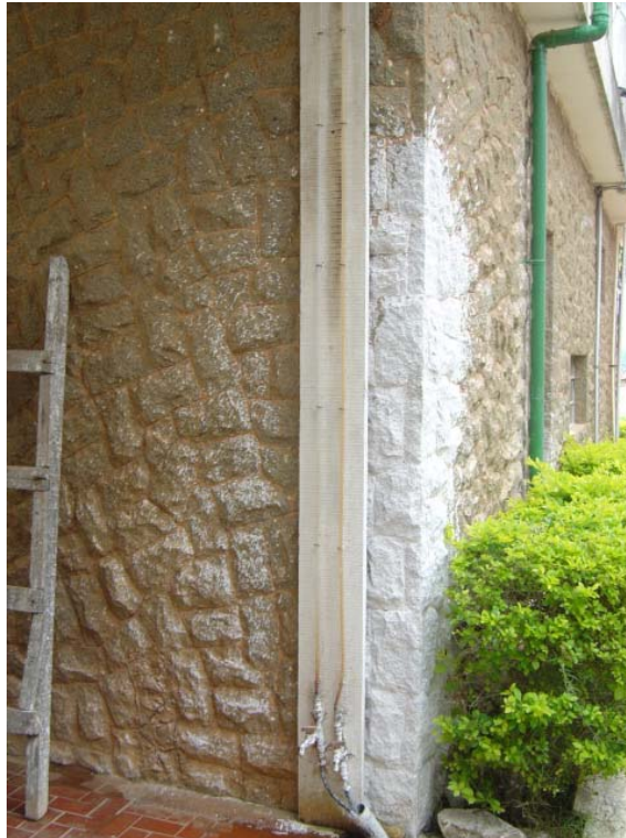
Figura 02 - Piezômetro instalado na ETA Santa Luzia.
