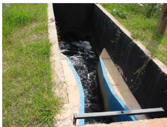
Figura 10 – DAE Valinhos: calha Parshall na saída da ETE (sensor a ser instalado)
