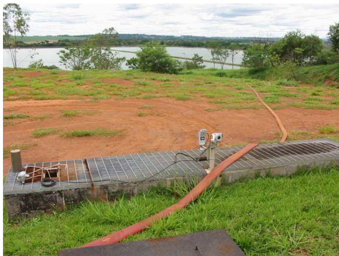
Figura 07 – Rhodia: sistema de medição por calha Parshall com transmissão de dados por sensor eletrônico no lançamento 01 – ETE Orgânicos (em teste)
