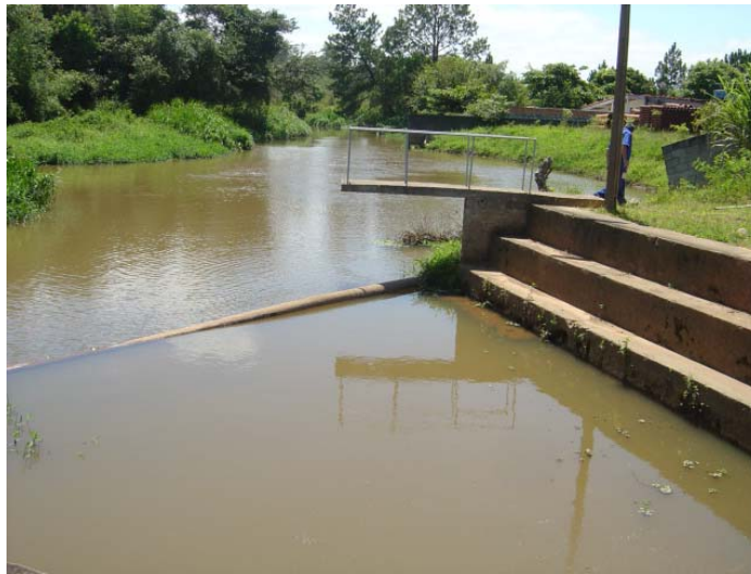
Figura 04 - Captação da ERA Terceira Centenária no rio Atibaia.
