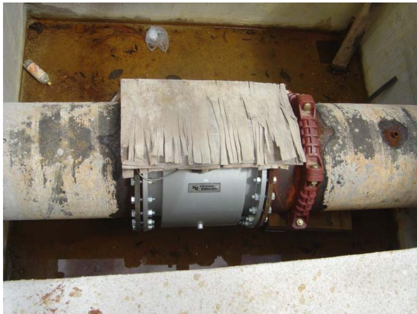
Figura 03 - Medição de vazão eletromagnético em fase de instalação - ETA Santa Luzia.
