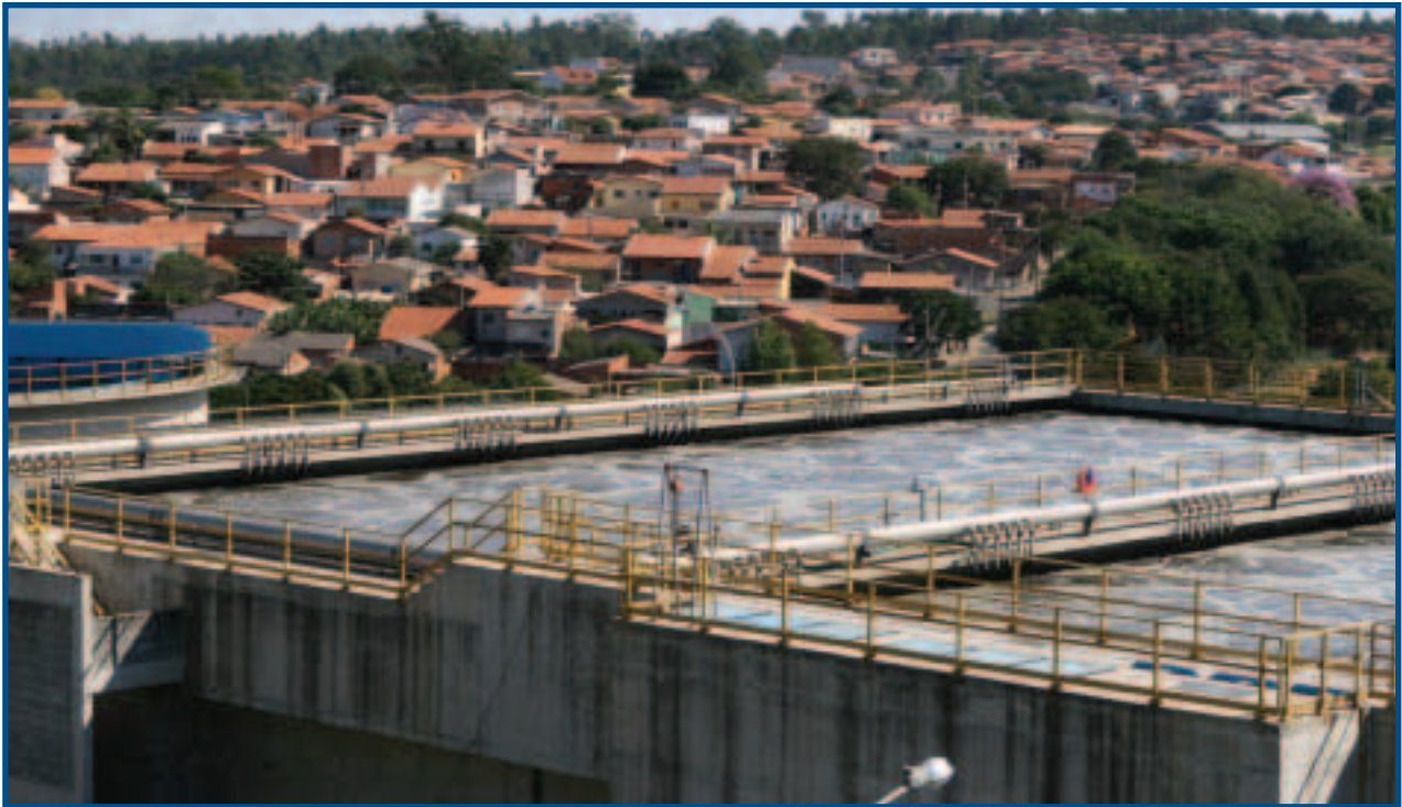
■ Figura 6 – Tratamento de esgoto – ETE Piçarrão, em Campinas (SP) – Foto: Tomas May
