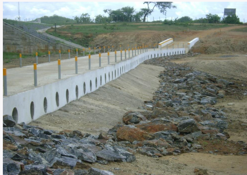
Passagem molhada após sua conclusão
