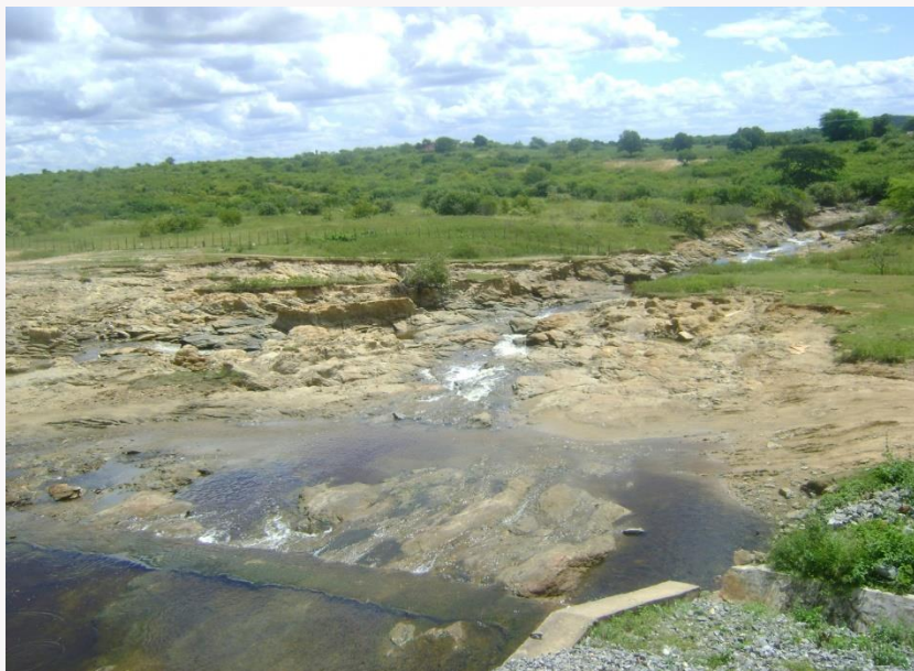
Detalhe da erosão regressiva
