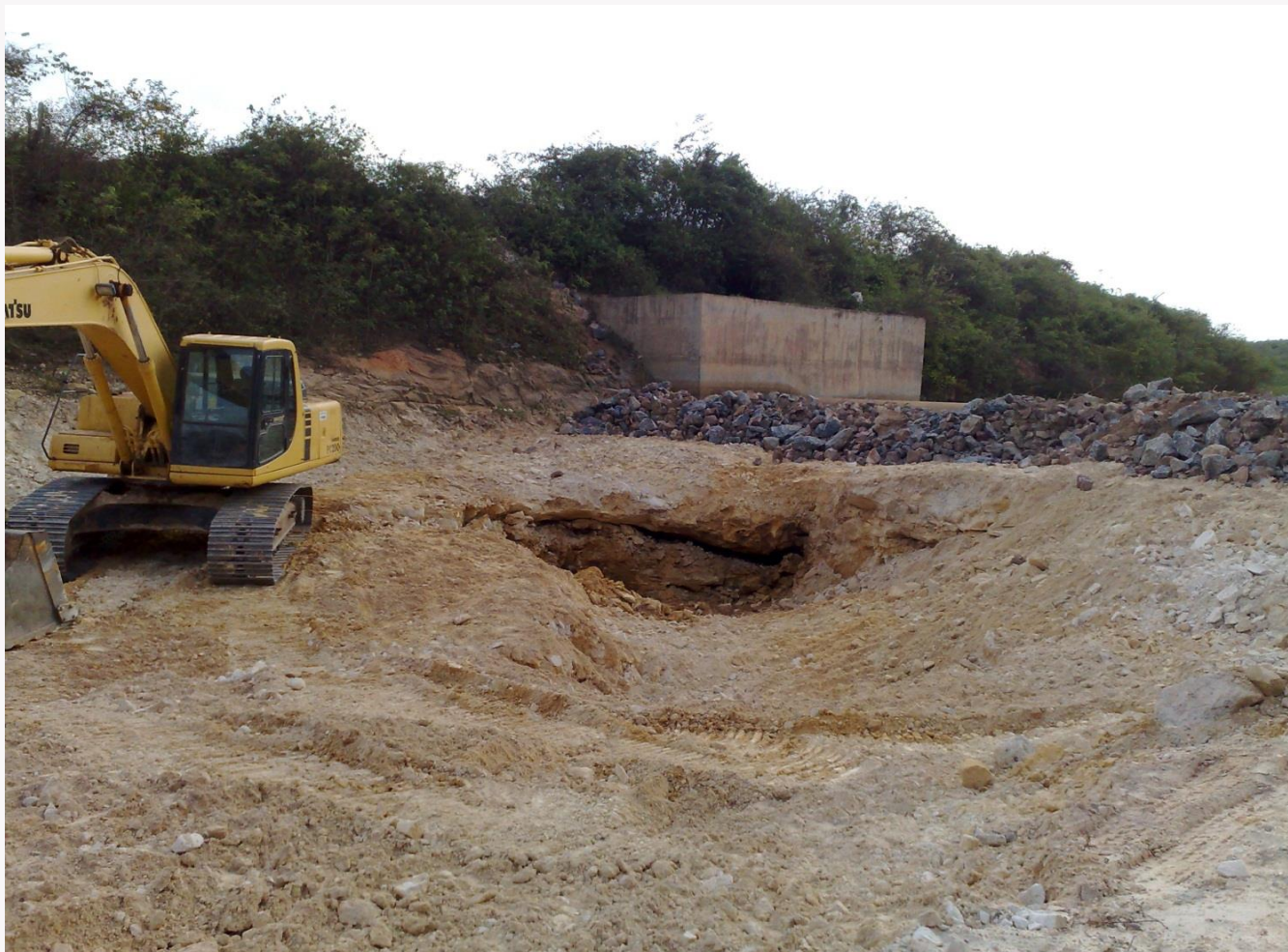
Recuperação do canal de aproximação do vertedouro
