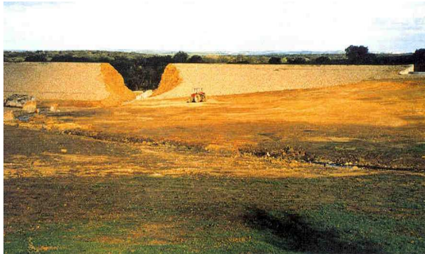
Barragem dos Hospitais, Portugal
