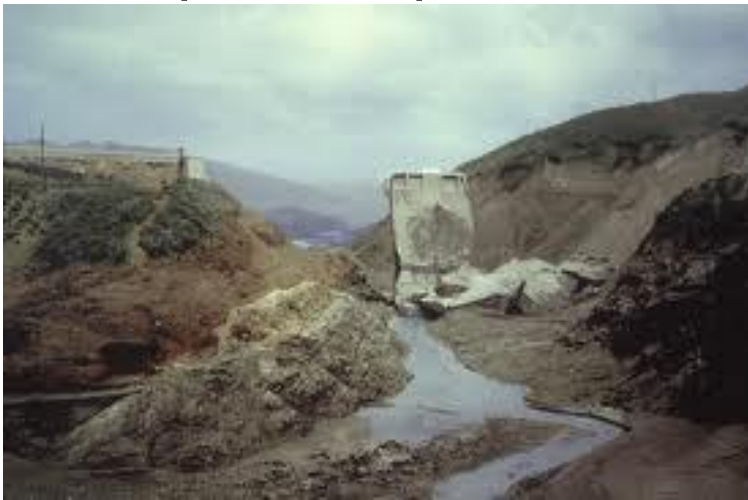
Vista de jusante da brecha da Barragem de St. Francis, EUA
