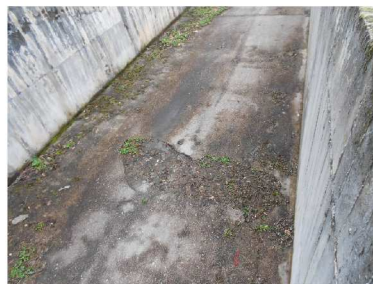
Erosão do concreto na base do canal
