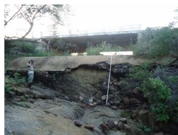
Erosão do concreto na base do canal
