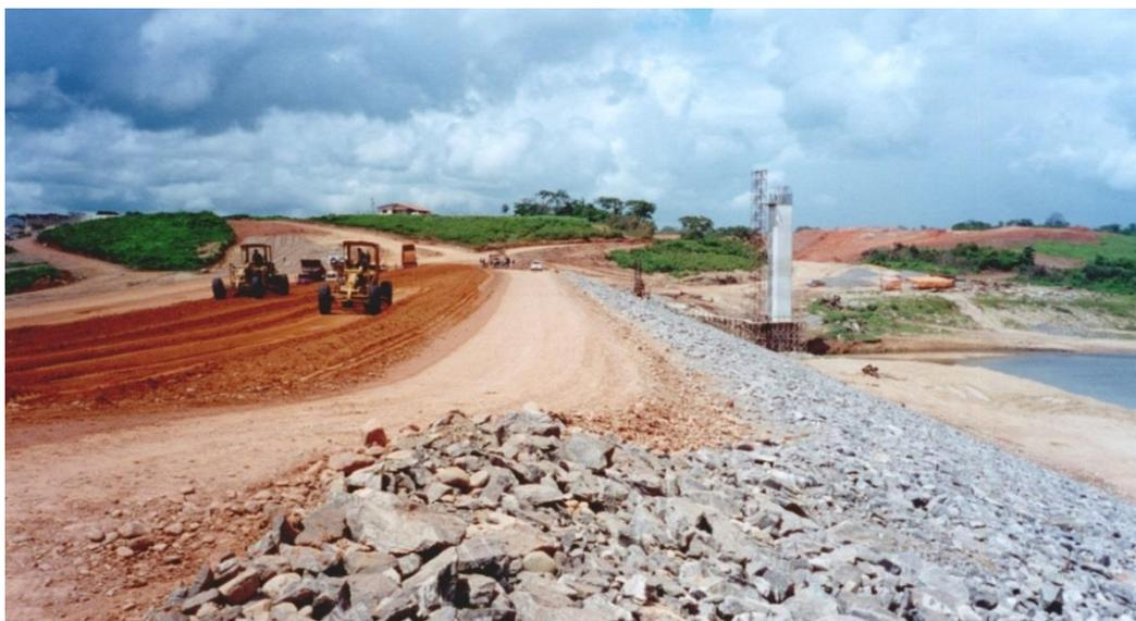
**Figura 8. Barragem de Aracoiaba, CE – construção H=35m, V=170 hm<sup>3</sup>, L=2000 m.**
